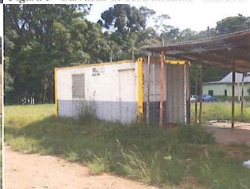
Figura 5 - Barracão de obra - nov/2016
