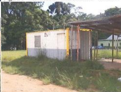
Figura 5 - Barracão de obra - nov/2016
