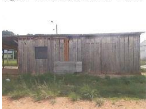
Figura 6 - Barracão de obra - nov/2016
