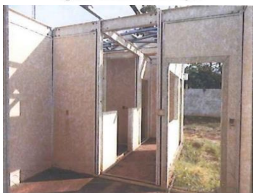
Figura 26: Bloco de Serviços
