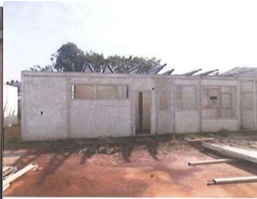
Figura 21: Bloco de Serviços
