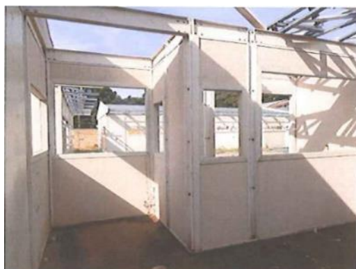
Figura 24: Bloco de Serviços
