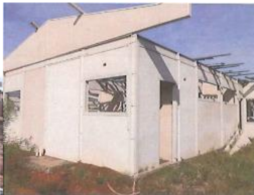
Figura 23: Bloco de Serviços
