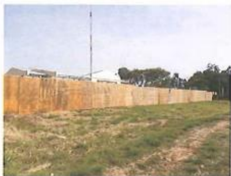
Figura 33 - Tapumes de proteção – mai/2017
