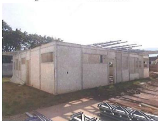
Figura 22: Bloco de Serviços
