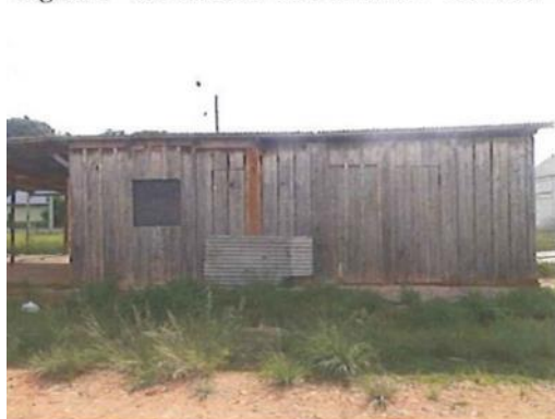
Figura 6 - Barracão de obra - nov/2016
