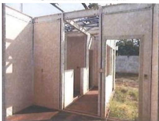
Figura 26: Bloco de Serviços
