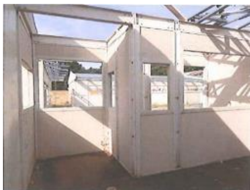
Figura 24: Bloco de Serviços
