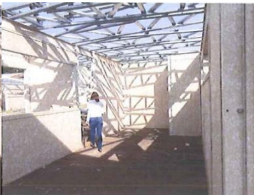
Figura 25: Bloco de Serviços
