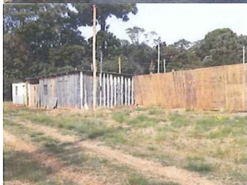
Figura 4 - Barracão de obra invadido - mai/2017
