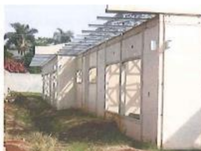
Figura 34 - Alarme instalado no local – mai/2017
