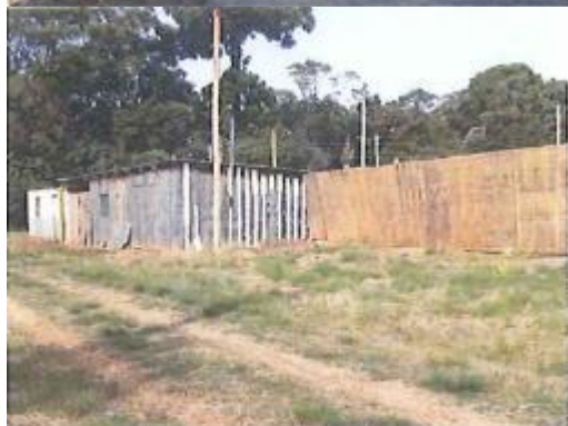
Figura 4 - Barracão de obra invadido - mai/2017
