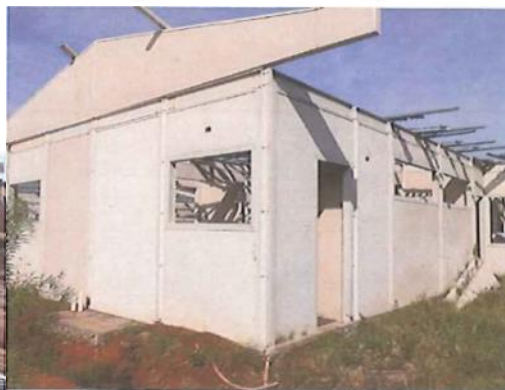
Figura 23: Bloco de Serviços
