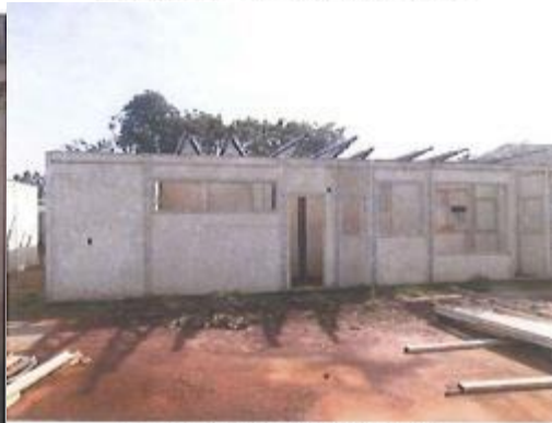
Figura 21: Bloco de Serviços
