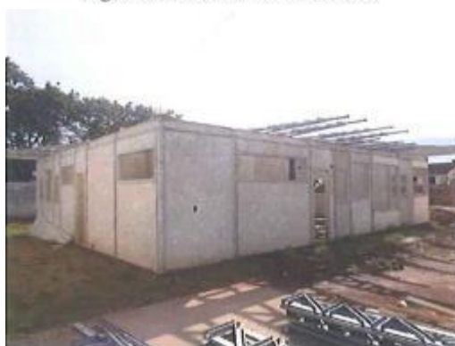
Figura 22: Bloco de Serviços
