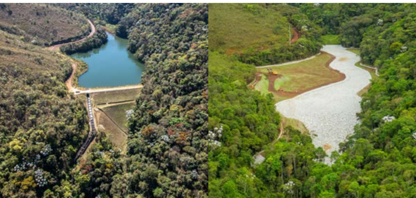
Barragem 8B: antes e depois do processo de descaracterização. Fotos: Vale
