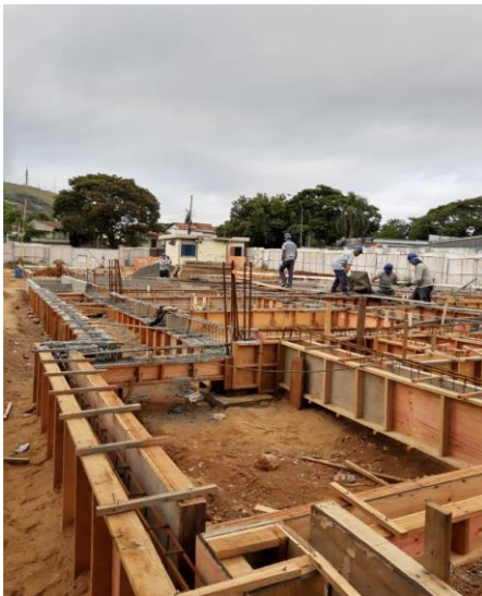
CF Campo da Tuca (em execução)
