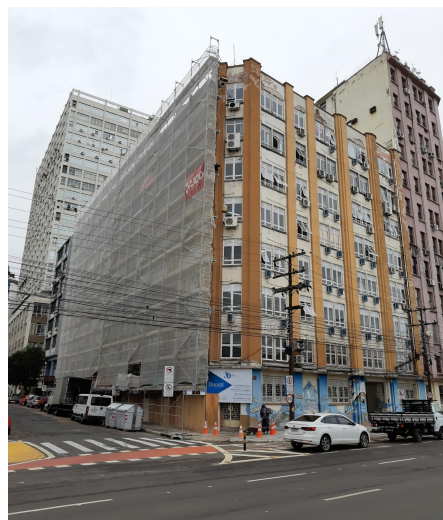
CS Santa Marta - Em execução
