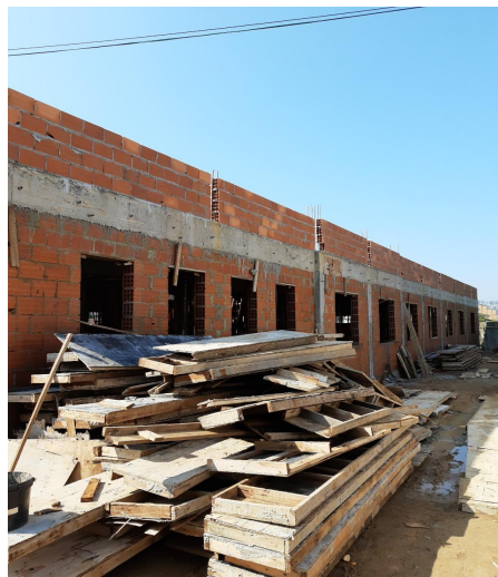
US Mato Sampaio - Em execução
