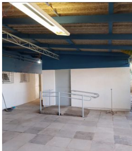
CF Álvaro Difini - Em execução
