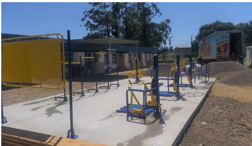
Academia Álvaro Difini - Em execução
