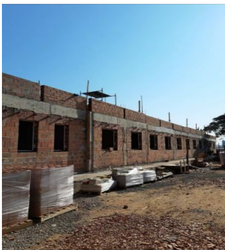
CF Campo da Tuca - Em execução
