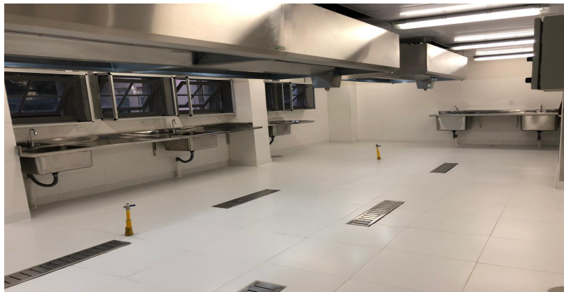
A1 - NUTRIÇÃO PAV1 - Concluída
