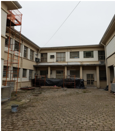
CS Navegantes - Em execução
