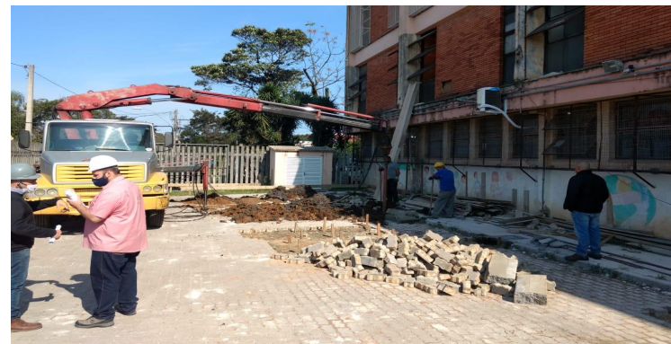
US Vila Cruzeiro (FASE) - Em execução
