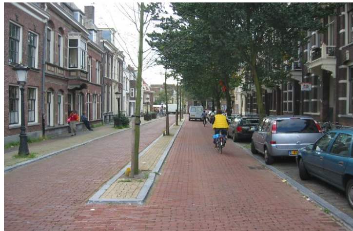
Figura 3-19- Via compartilhada com desenho induzindo o traffic calming
