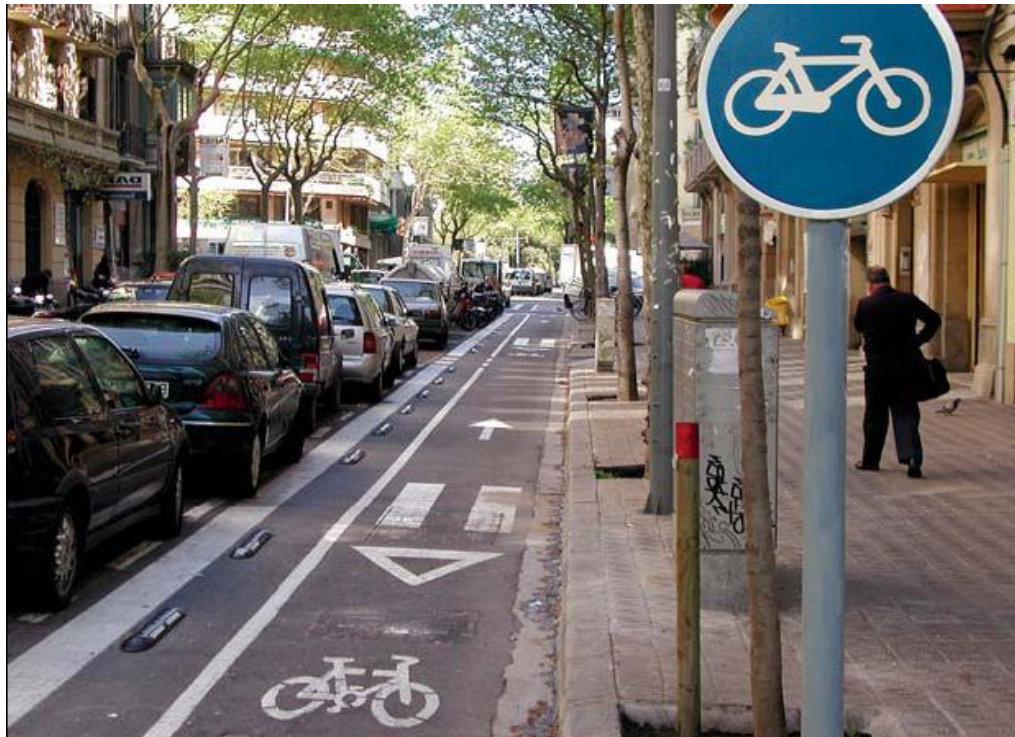
Figura 3-17 – Ciclofaixa à direita estacionamento dos carros de curta duração
