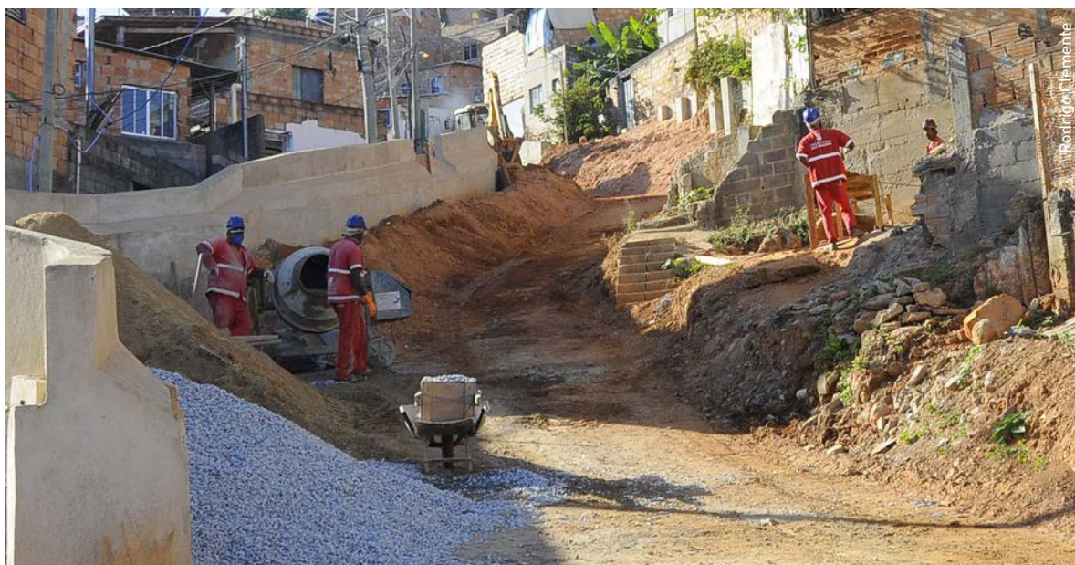
Obras Morro das Pedras
