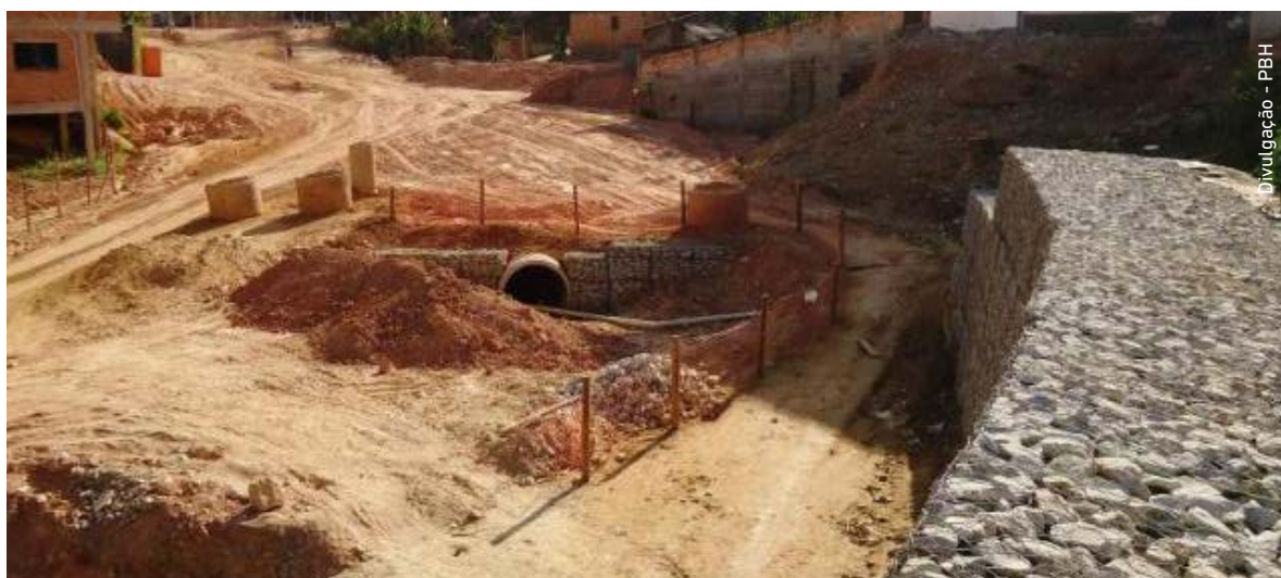
Obra de prevenção de enchentes na rua Marselhesa, Barreiro
